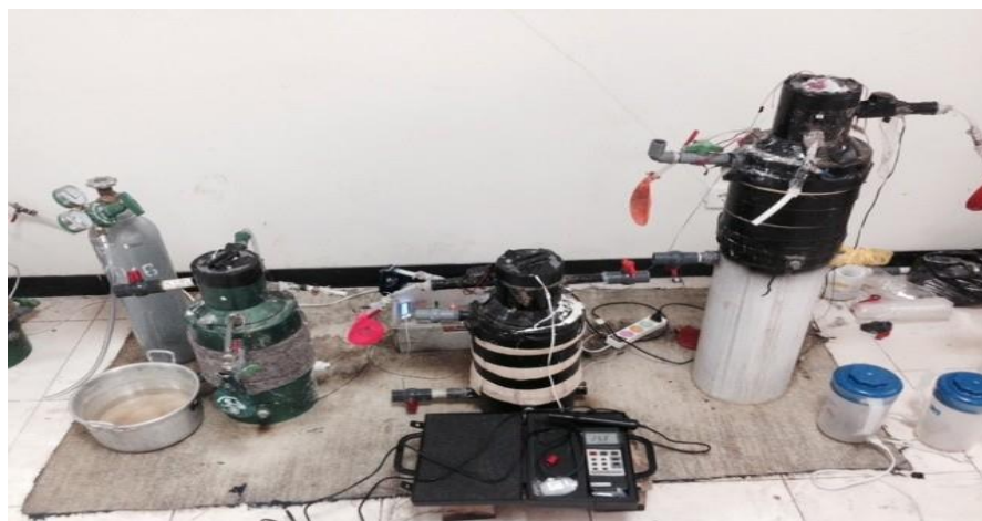
Gambar 3.1 Realisasi Digester Biogas.
