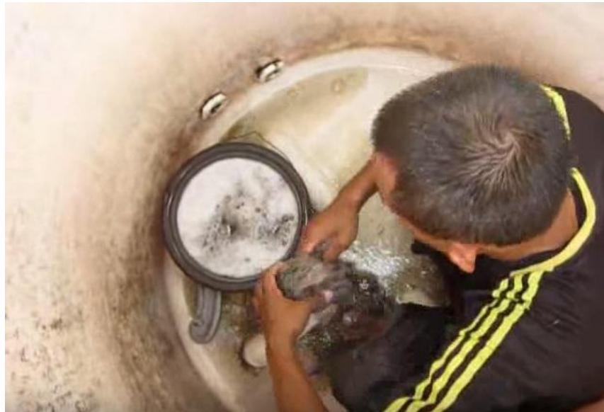
Gambar 1.2 Metode pembersihan toren air secara manual (Sumber data : Data lapangan 2015)
