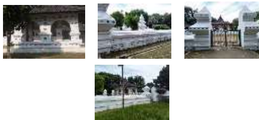
Gambar 3.1 Bangunan Siti Inggil Dan Pagar Keraton Kanoman
