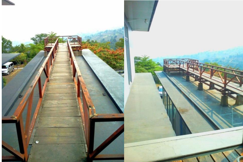
Gambar 2.2.2 Jembatan Di Lantai Dua Café Lawangwangi Bandung ( Sumber : Pribadi, 2018 )
