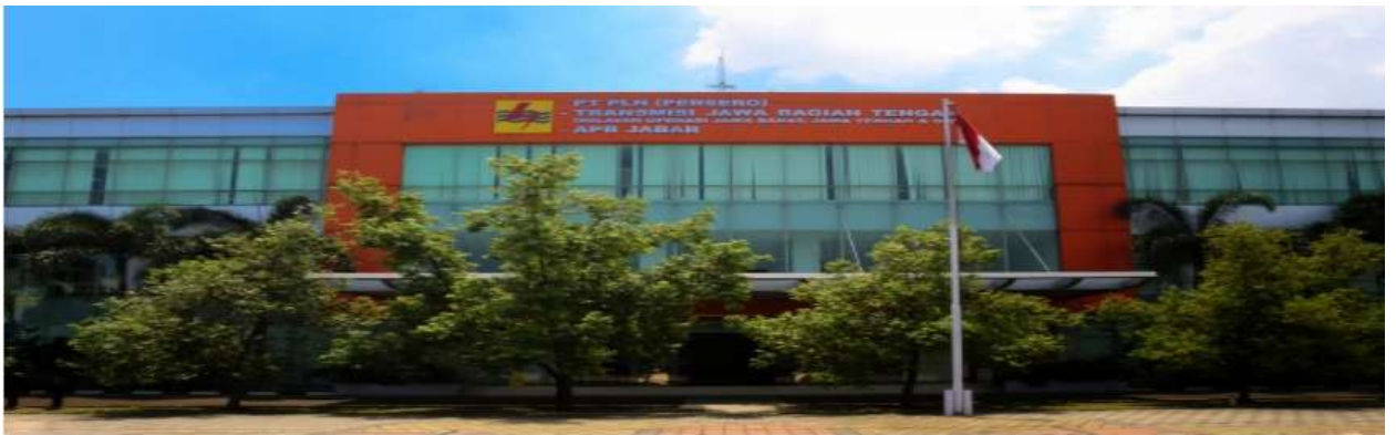
Gambar 1.2 PT.PLN (Persero) Transmisi Jawa Bagian Tengah
