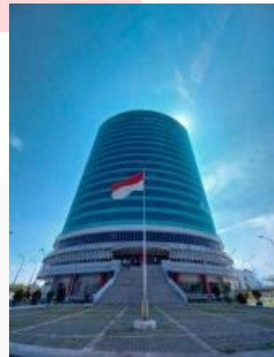
GAMBAR 2 Tampak Depan Gedung TULT
